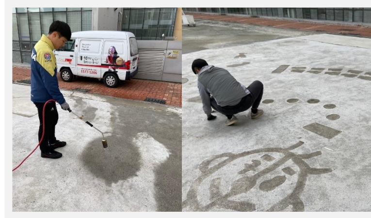
① 이물질 제거 / ② 프라이머 작업
